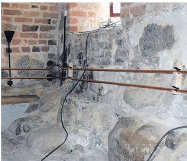
Kupferrohre leiten die Wärme in die Wand
